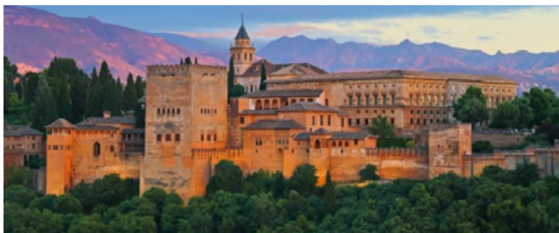
Alhambra de Granada, Se edificó hace más de 600 años y una gran parte de sus muros están contruidos con tierra,
